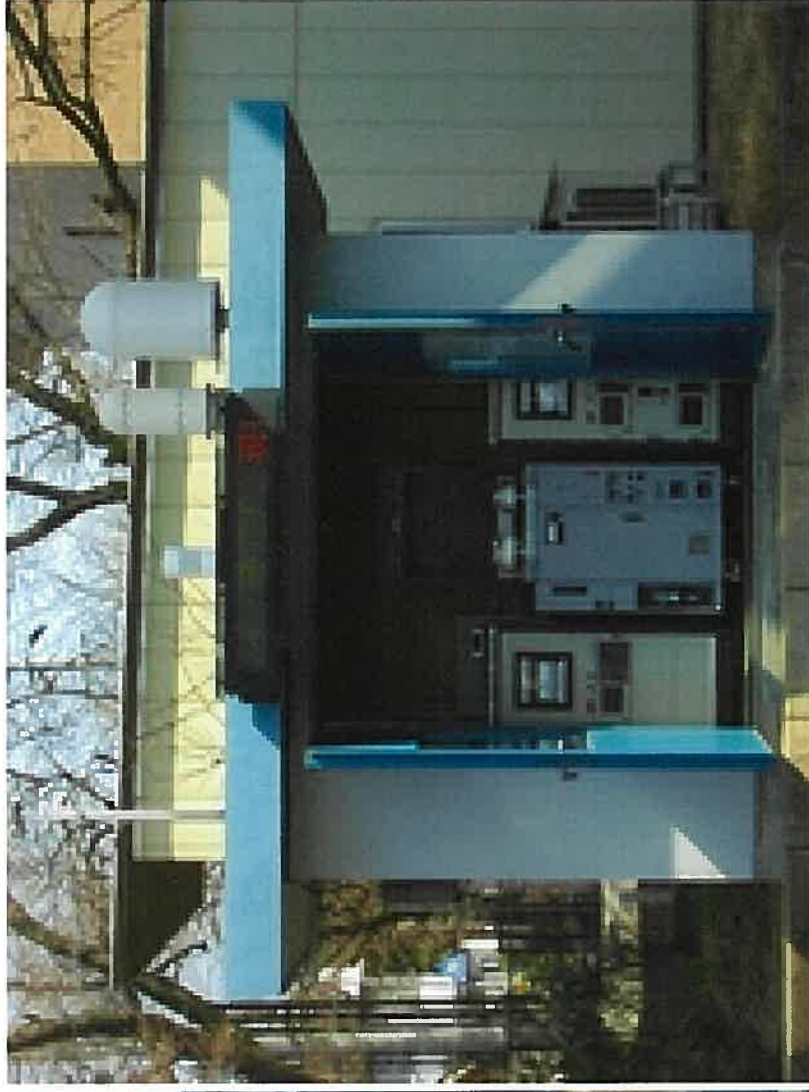
【図表6】 モニタリングポストの外観と内部の写真
